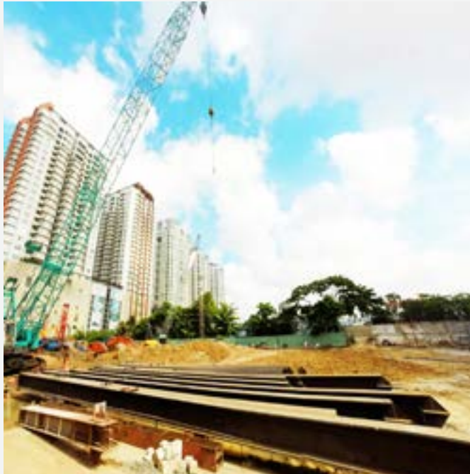
LẮP DỰNG KINGPOST CÔNG TRÌNH THE PARK AVENUE
