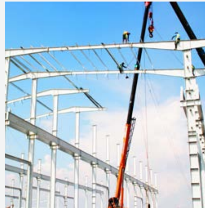
LẮP DỰNG KHUNG NHÀ THÉP CÔNG TRÌNH NHÀ MÁY NAM HUNG
