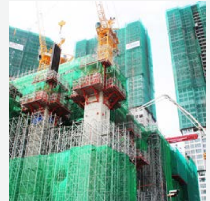
LẮP DỰNG KẾT CẤU LỖI THÉP CÔNG TRÌNH TÒA CAO ỐC LANDMARK 81
