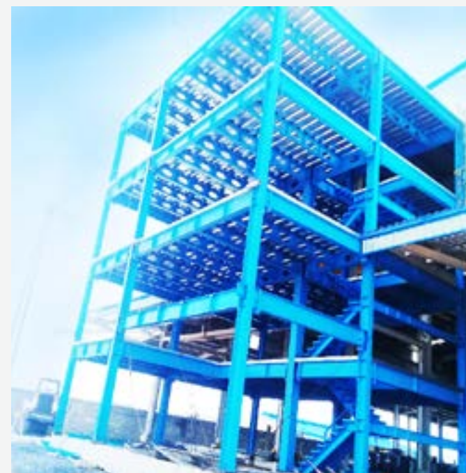
LẮP DỰNG NHÀ VĂN PHÒNG NHÀ XƯỞNG NAM HUNG
