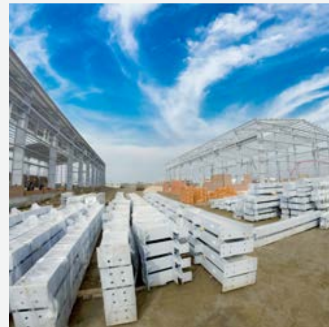
LẮP DỰNG NHÀ MÁY PHỤC VỤ DI DỜI SÓM BA SON
