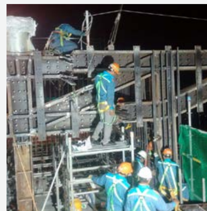
LẮP DỰNG KẾT CẤU LỖI THÉP CÔNG TRÌNH TÒA CAO ỐC LANDMARK 81
