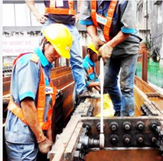
LẮP DỰNG KINGPOST CÔNG TRÌNH CAO ỐC VĂN PHÒNG ETOWN CENTRAL
