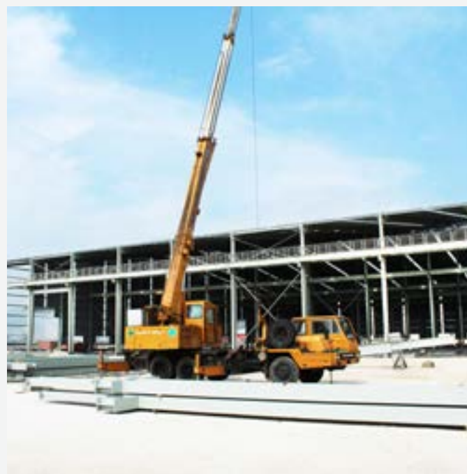
LẮP DỰNG KÉO NHÀ THÉP NHÀ XƯỞNG TÓN HOA SEN HÀ NAM
