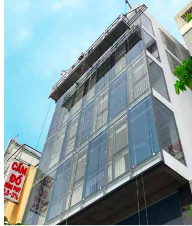
NHÀ Ở - SỐ 4 NGUYỄN VĂN CỪ, QUẬN 1 HOUSING - NO. 4 NGUYEN VAN CU, DISTRICT 1
