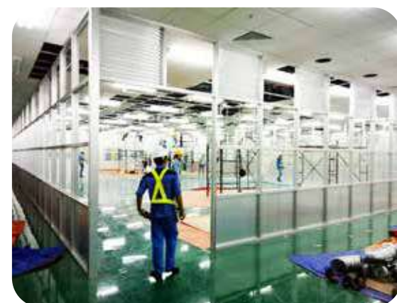
LẮP DỰNG KHUNG KÈO SKELETON FRAME ERECTION
