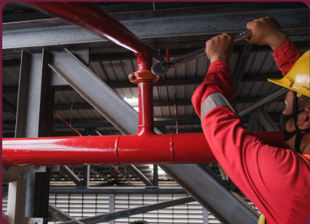
THI CÔNG HỆ THỐNG PCCC FIRE PROTECTION SYSTEM INSTALLATION
