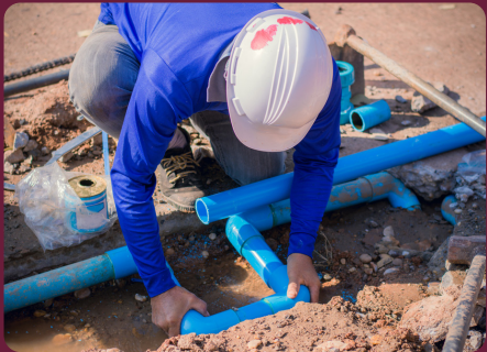
LẮP ĐẶT HỆ THỐNG M&E M&E SYSTEM INSTALLATION
