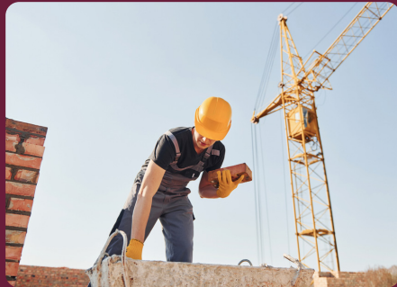
THI CÔNG XÂY TÔ BRICKWORK CONSTRUCTION
