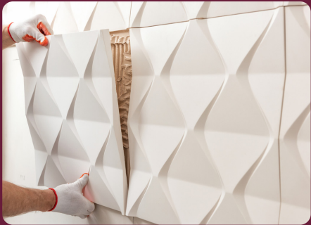
THI CÔNG NỘI THẤT INTERIOR CONSTRUCTION
