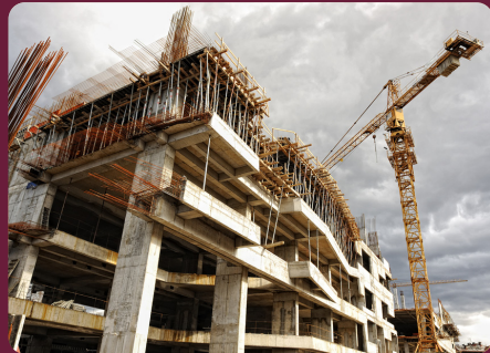
THI CÔNG KHUNG NHÀ FRAME CONSTRUCTION
