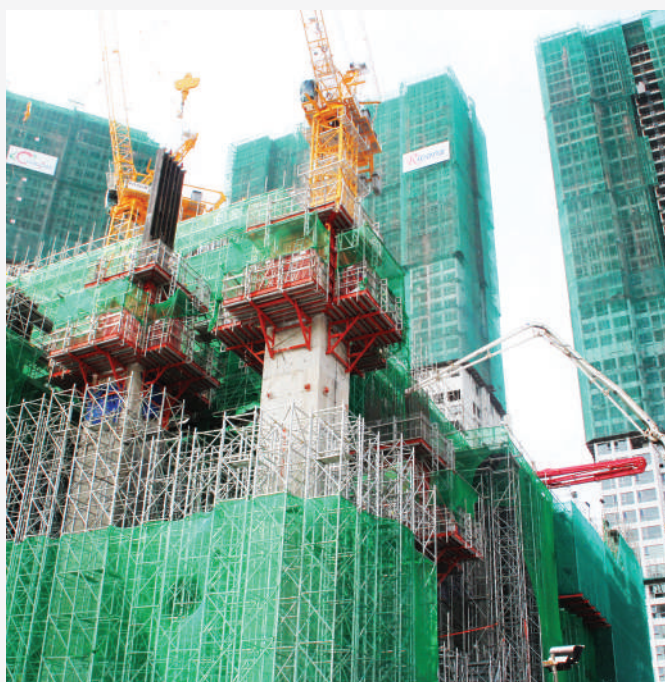
LẮP DỰNG KẾT CẤU LÒI THÉP CÔNG TRÌNH TÒA CAO ỐC LANDMARK 81
