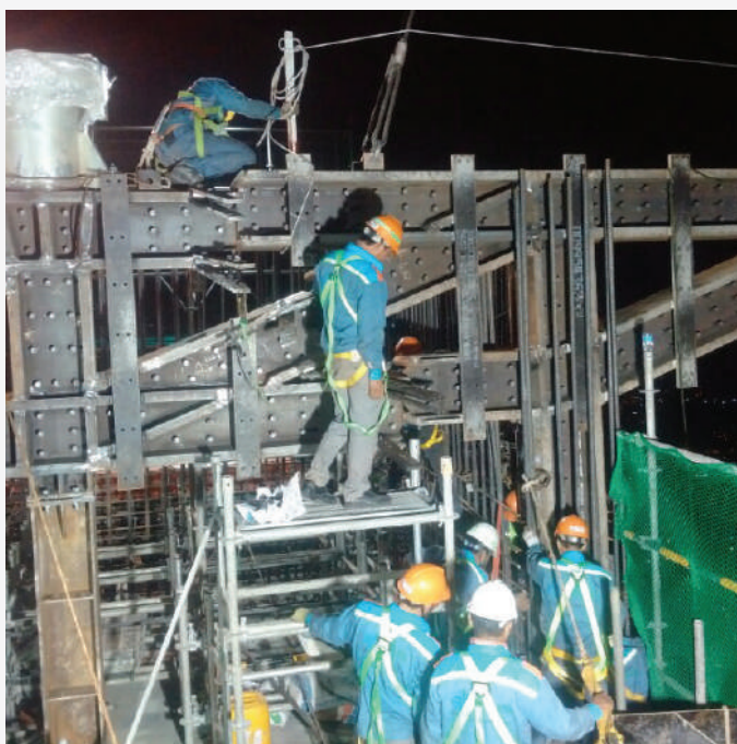
LẮP DỰNG KẾT CẤU LÒI THÉP CÔNG TRÌNH TÒA CAO ỐC LANDMARK 81
