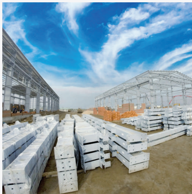
LẮP DỰNG NHÀ MÁY PHỤC VỤ DI DỜI SỚM BA SƠN
