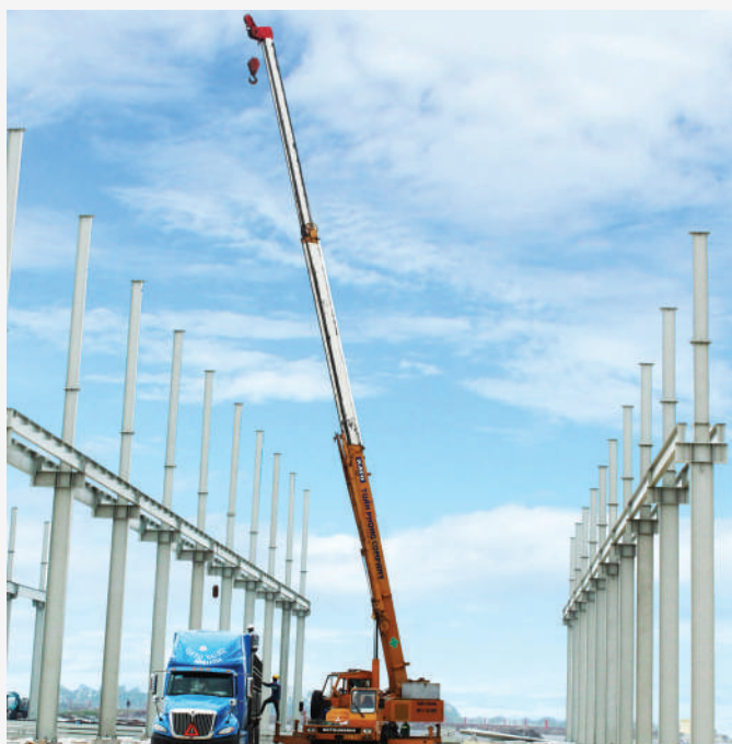
LẮP DỰNG KHUNG NHÀ THÉP CÔNG TRÌNH NHÀ MÁY HOA SEN HÀ NAM
