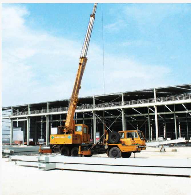
LẮP DỰNG KÉO NHÀ THÉP NHÀ XƯỞNG TÔN HOA SEN HÀ NAM
