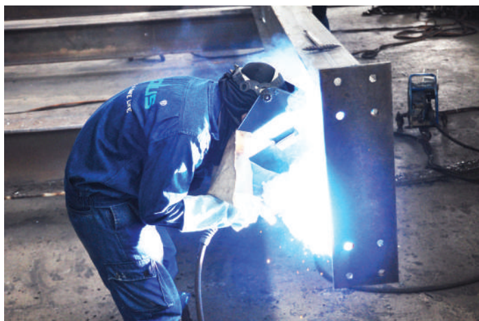
HÀN HOÀN THIỆN
