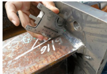
Kiểm Tra Đường Hàn | Visual Inspection of Weld Line
