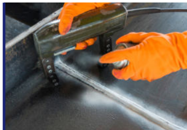
Kiểm Tra Mối Hàn | Inspection of Weld Joints
