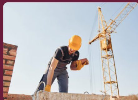
THI CÔNG XÂY TÔ
