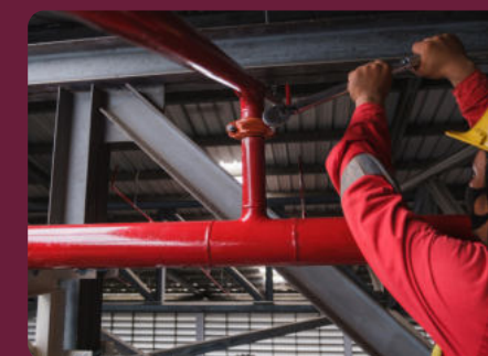
THI CÔNG HỆ THỐNG PCCC
