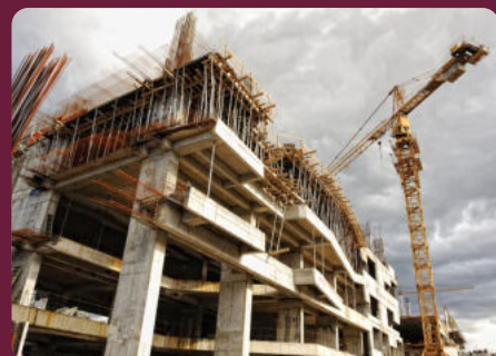
THI CÔNG KHUNG NHÀ
