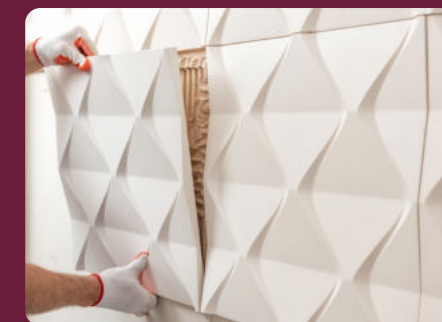
THI CÔNG NỘI THẤT
