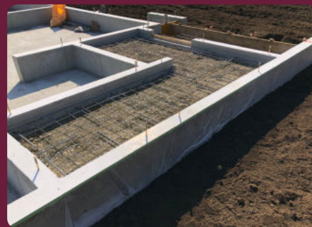
THI CÔNG MÓNG
