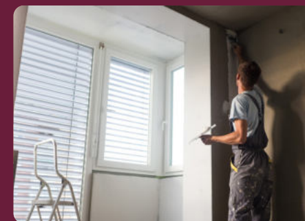
THI CÔNG SƠN
