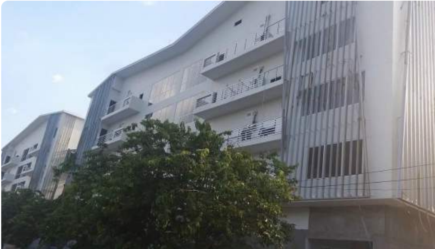
27 DỰ ÁN TÒA NHÀ VĨNH LONG - HÒA BÌNH 和平-永隆大楼项目
