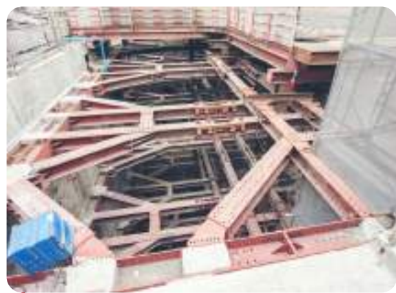
HỆ GIÀNG CHỐNG 支撑系统
