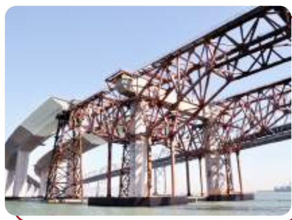
CẦU, CẦU VƯỢT 桥梁、跨线桥
