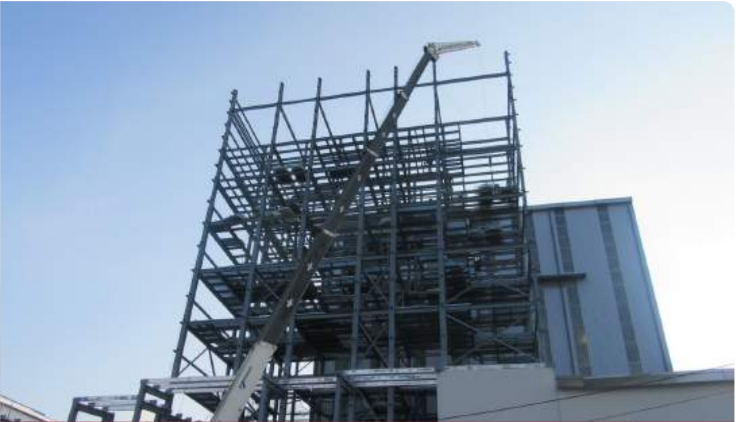
20 DỰ ÁN NHÀ XƯỞNG HYOSUNG - QUẢNG NAM 广南 - HYOSUNG工厂项目
