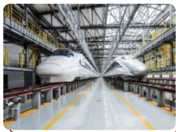
ĐƯỜNG SẮT 铁路
