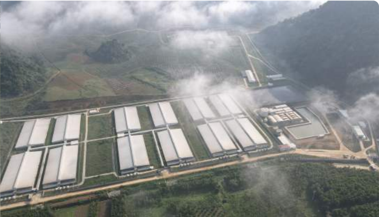
2 CÔNG TRÌNH TRẠI HEO THỊT 36000 养猪场 36000 工程
