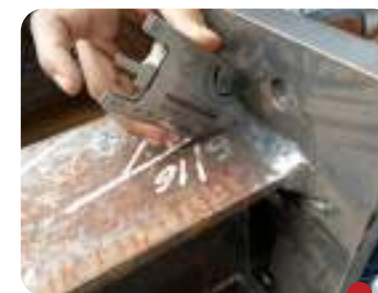
Kiểm Tra Mối Hàn | Welding inspection
