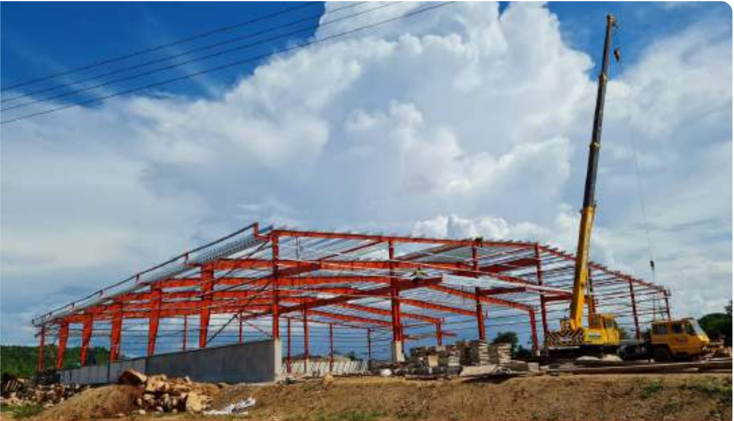
18 DỰ ÁN FOOKTIEN BUILDING 2 - THÁI LAN FOOKTIEN BUILDING 2 PROJECT - THAILAND
