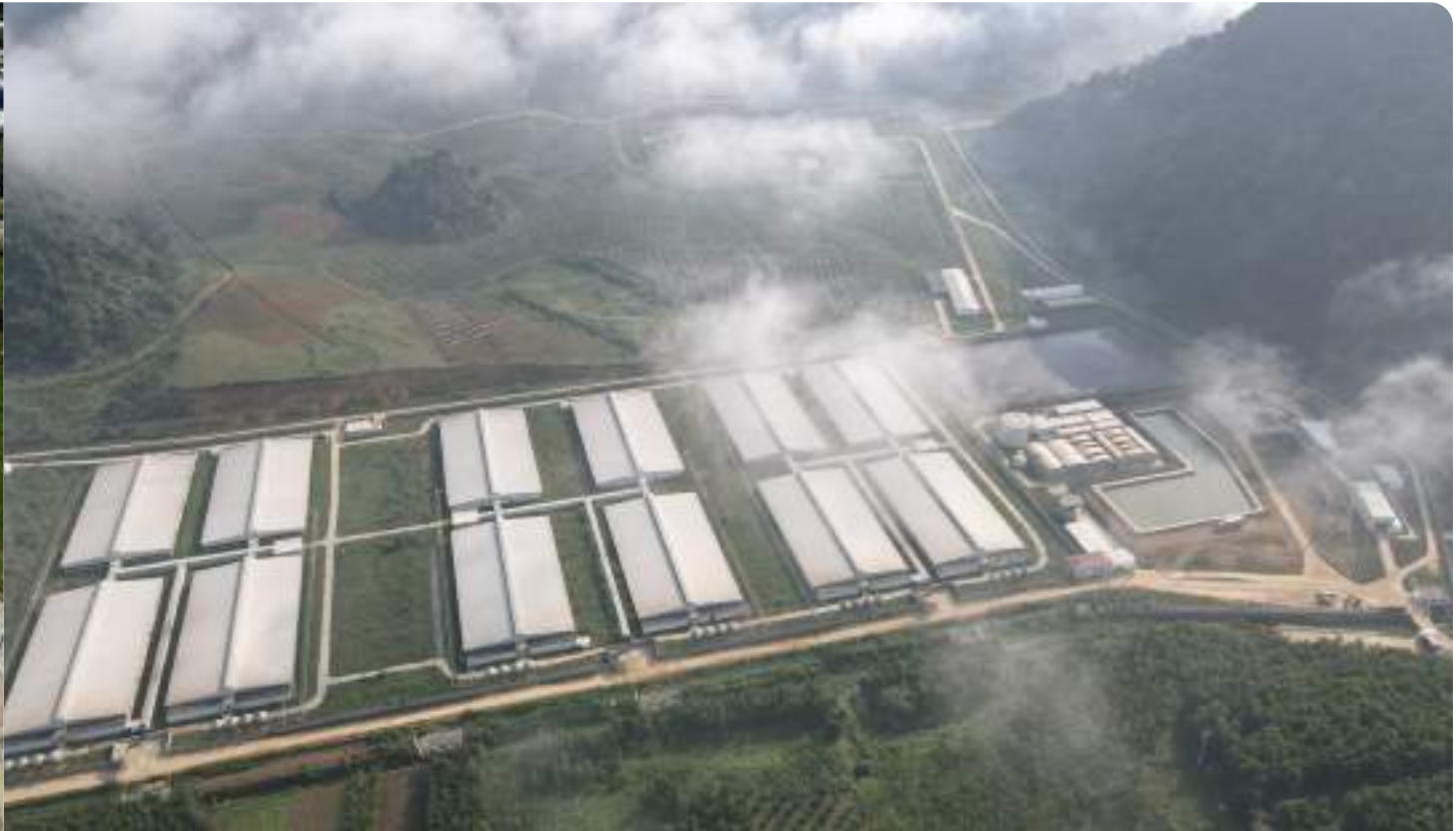
2 CÔNG TRÌNH TRẠI HEO THỊT 36000 NEW HOPE BINH PHUOC FARM
