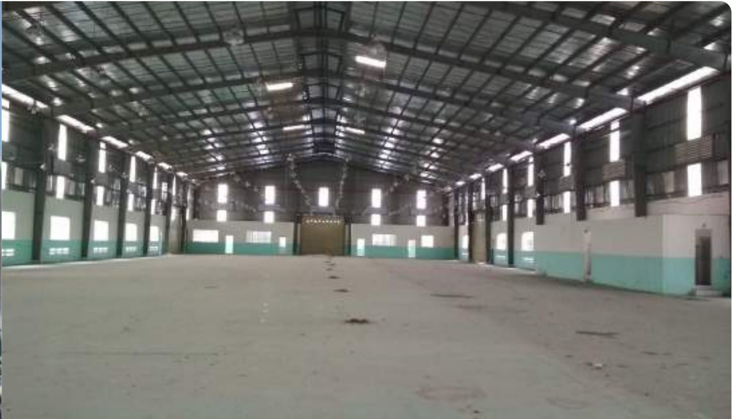
22 NHÀ XƯỞNG QUỐC THẮNG QUOC THANG FACTORY
