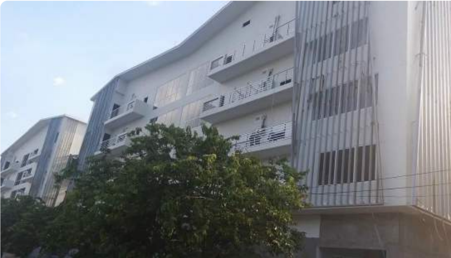
27 DỰ ÁN TÒA NHÀ VĨNH LONG - HÒA BÌNH VINH LONG - HOA BINH BUILDING PROJECT
