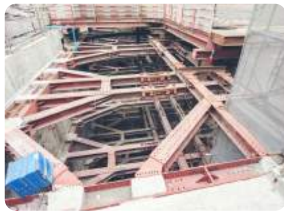
HỆ GIÀNG CHỐNG SHORING SYSTEM
