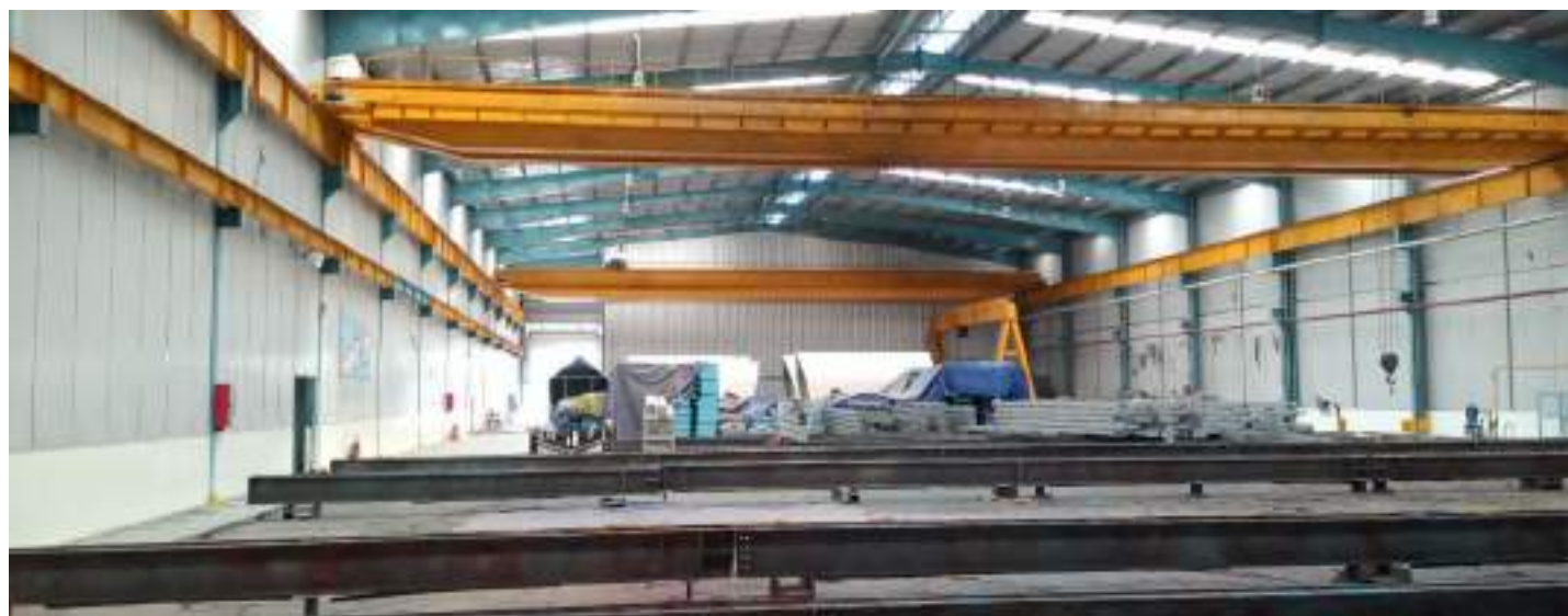
BÊN TRONG NHÀ XƯỞNG
