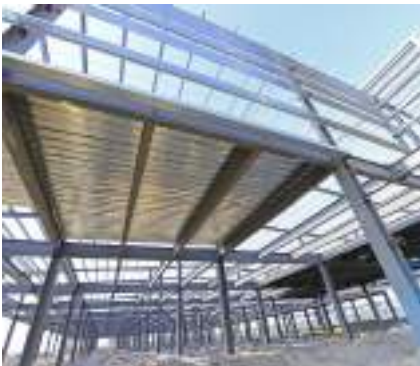
LIÊN KẾT DẦM SÀN CHÍNH VỚI CỘT KHUNG CHÍNH
