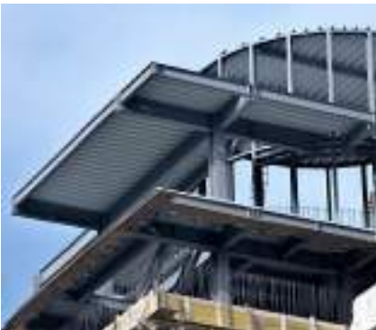
LIÊN KẾT DẦM PHỤ VÀO DẦM CHÍNH
