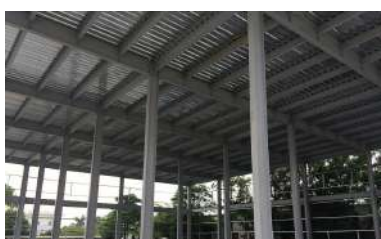
HỆ DẦM SÀN DECKING
