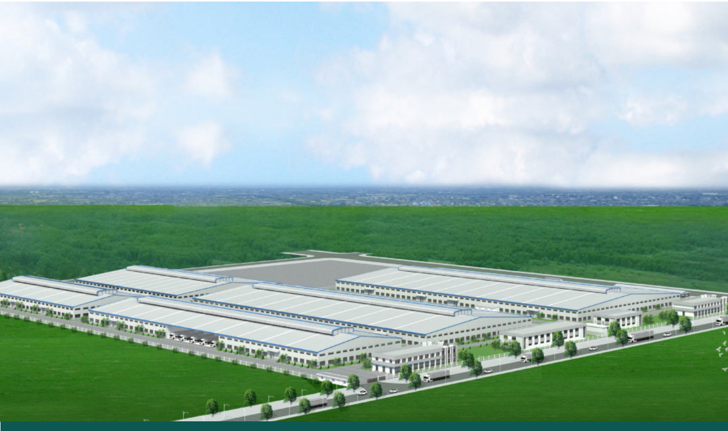
18. NHÀ MÁY SẢN XUẤT DỤNG CỤ THỂ THAO BESTWAY SPORTS EQUIPMENT FACTORY BESTWAY
