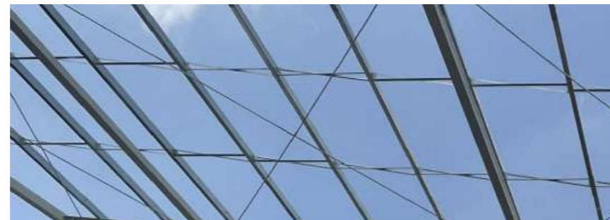
TRÁP GIẪNG & THANH GIẪNG | SAG ARRESTOR & BRACE ROD
